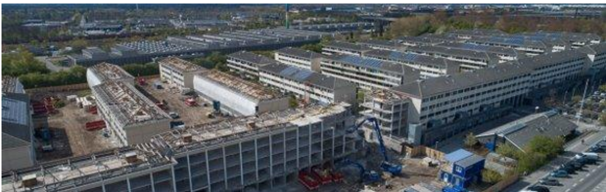
Demolition of Taastrupgård
